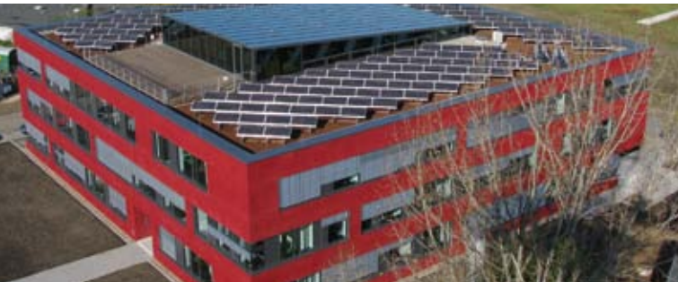
Passivhaus-Bürogebäude „etrium“ in Köln-Vogelsang.
